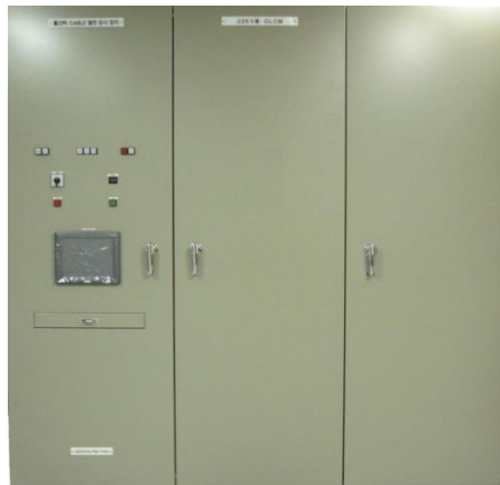
<OLCM-E 고정설치식 외관 예, 90개 Feeder>
